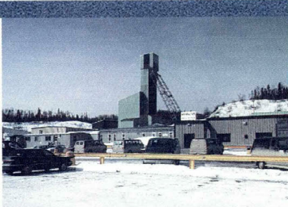
PHOTO 67 : Le haut bâtiment à la mine Winston Lake est le chevalement. Il est construit au-dessus du puits de la mine et abrite le matériel de levage pour transporter les travailleurs, les fournitures, et le minerai.
